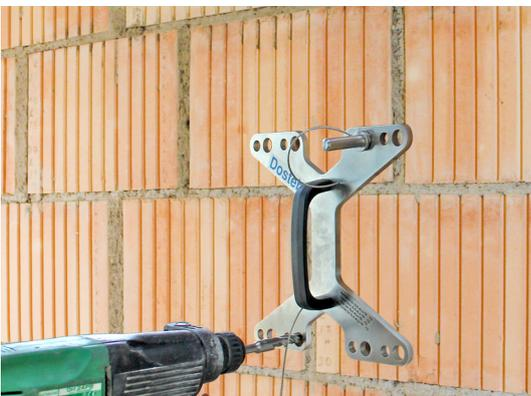
Bei der Bohrlehre für SLK®-ALU-TR / -TQ ein Positionierbolzen in das dementsprechende Loch stecken.
