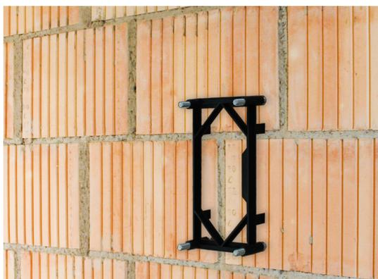
Insérez les tiges filetées et alignez-les exactement en utilisant le gabarit de perçage correspondante.
