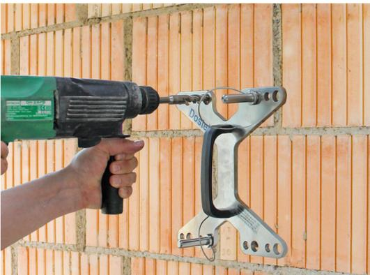
Bei der Bohrlehre für SLK®-ALU-TR / -TQ zweiten Positionierbolzen in das dementsprechende Loch stecken.
