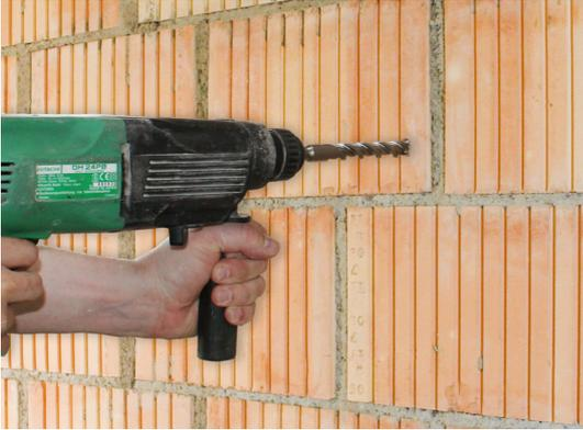
Erstes Bohrloch anzeichnen und bohren.
