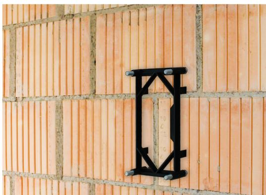
Ustaw pręty gwintowane i wyrównaj je precyzyjnie, nakładając odpowiedni przyrząd do ustawiania.
