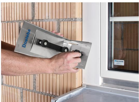
Régler le gabarit de positionnement en fonction de la partie visible du cadre souhaitée.
