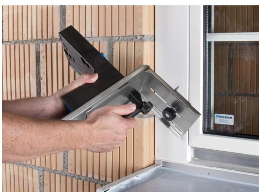
Inserire il posizionamento calibro sul supporto per imposte K1-PE, K1-PU o staffe TRA-WIK®-PU.
