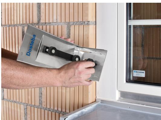
Ustawić szablon do osadzania na wybrany wymiar widoczny obramowania.
