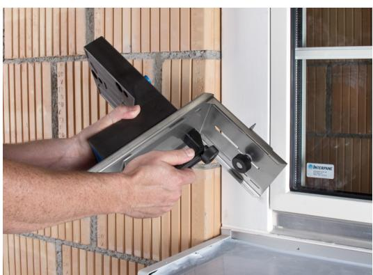
Faire glisser le gabarit de positionnement sur l'élément pour fixation des gonds K1-PE, K1-PU ou equerres TRA-WIK®-PU.
