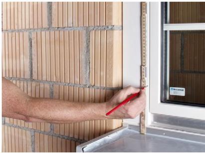
Marcare l'altezza nel punto centrale del elemento di supporto cardini K1-PU sul muro.
