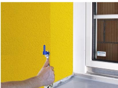
Avvitare componenti nell'elemento di supporto cardini K1-PU.
