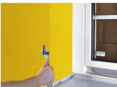
Schraubenlänge ergibt sich aus der Verschraubungstiefe, der Dicke der Beschichtung und der Dicke des Anbauteils.
