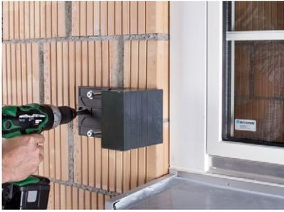
Klobentragelement K1-PU auf Fassadenflucht ausrichten, danach Schraubdübel anziehen.
