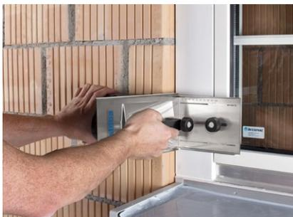
Klobentragelement K1-PU mit aufgeschobener Setzlehre auf die eingezeichnete Höhe halten und Setzlehre bis an den Fensterrahmen führen. Der Strich auf dem Mauerwerk muss durch den mittigen Schlitz in der Setzlehre sichtbar sein. Der Anschlag muss am Fensterrahmen sauber aufliegen.
