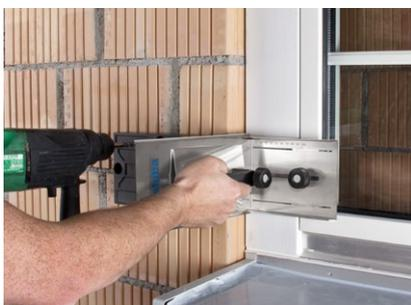
Erstes Bohrloch bohren und Schraubdübel in das dementsprechende Loch stecken.
