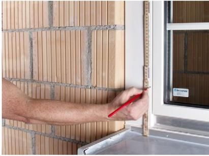
Höhe mittig Klobentragelement K1-PU auf Mauerwerk einzeichnen.
