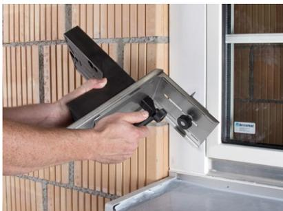
Inserire il posizionamento calibro sull'elemento di supporto cardini K1-PU.
