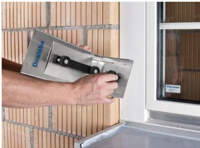
Regolare il posizionamento calibro con la misura di telaio visibile desiderata.
