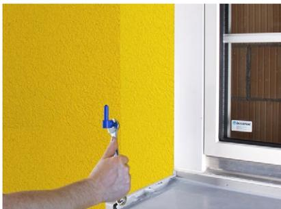
Anbauteil in das Klobentragelement K1-PU verschrauben.
