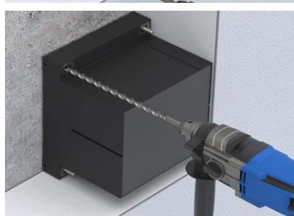
Bei der Schwerlastkonsole SLK®-ALU-TQ eine Injektions-Gewindestange in das dementsprechende Loch der Schwerlastkonsole SLK®-ALU-TQ stecken und drittes und viertes Bohrloch bohren.
