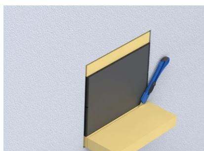
Füllstücke einschieben und fassadenbündig ablängen.
