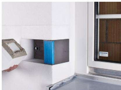
Adattare i pannelli isolanti senza fughe. Contrassegnare la posizione precisa, in modo che l'elemento di supporto cardini K1-PE sia nuovamente individuabile dopo l'applicazione del rivestimento in intonaco.
