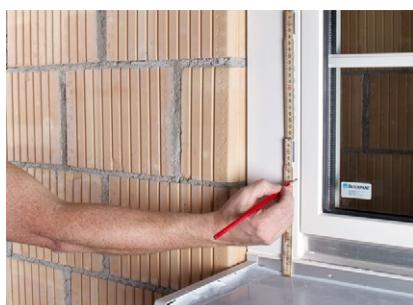
Es empfiehlt sich, die Klobentragelemente K1-PE vor dem Kleben der Dämmplatten zu versetzen.
