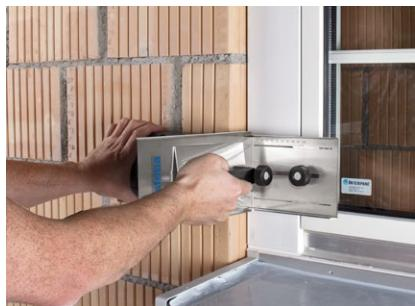
Tenere gli elementi di supporto cardini K1-PE con il posizionamento calibro inserito all'altezza marcata e portare il posizionamento calibro a contatto con il telaio della finestra. Il segno sul muro deve essere visibile attraverso la fessura centrale del posizionamento calibro. La battuta deve aderire bene al telaio della finestra.
