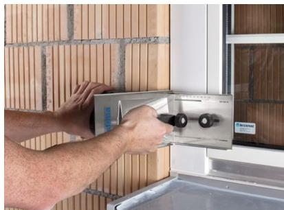
Klobentragelement K1-PE mit aufgeschober Setzlehre auf die eingezeichnete Höhe halten und Setzlehre bis an den Fensterrahmen führen. Der Strich auf dem Mauerwerk muss durch den mittigen Schlitz in der Setzlehre sichtbar sein. Der Anschlag muss am Fensterrahmen sauber aufliegen.
