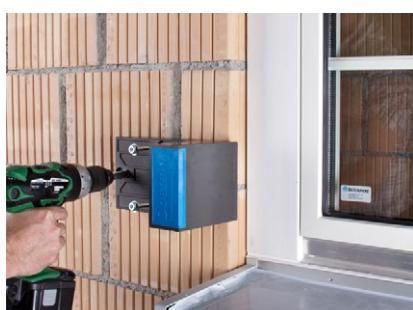
Mit den Stellfüßen Klobentragelement K1-PE auf Fassadenflucht ausrichten, danach Schraubdübel anziehen.
