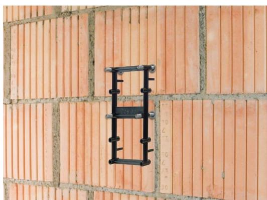
Gewindestangen setzen und durch aufstecken der jeweiligen Setzlehre genau ausrichten.
