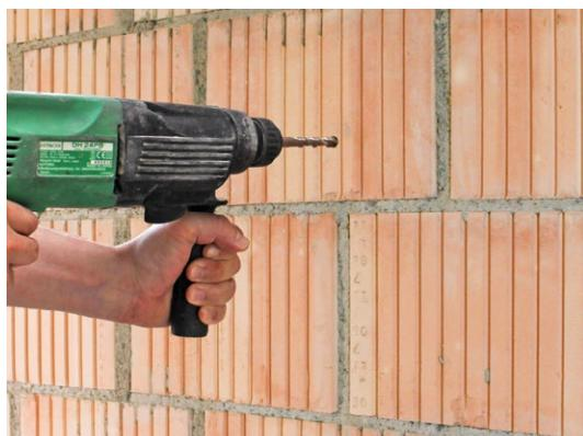
Erstes Bohrloch anzeichnen und bohren.
