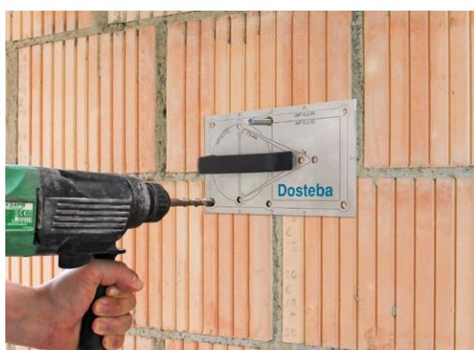
Quando si usa la dima di foratura per UMP®, TRA-WIK® e TWL®, inserire un aste filettate nel foro corrispondente.
