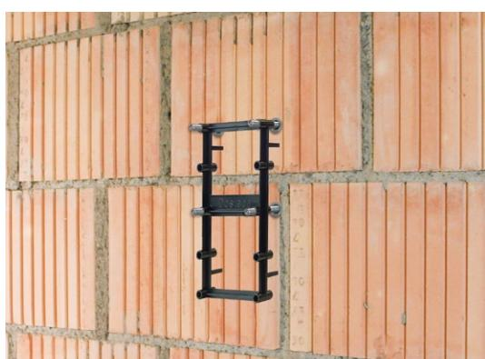
Positionner les tiges filetées et les aligner exactement en insérant le gabarit de positionnement correspondante.
