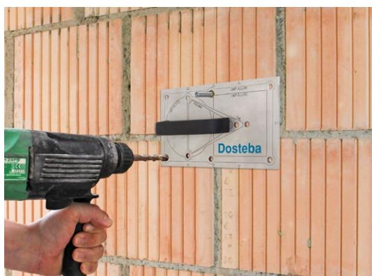
Insérer une tige filetée dans le trou correspondant du gabarit de perçage pour UMP®, TRA-WIK® et TWL®.
