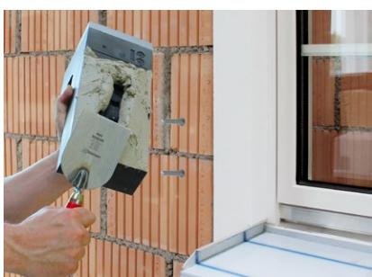
Applicare della malta adesiva sulla superficie d'incollaggio delle staffe TRA-WIK®-ALU-RL. L'elemento deve essere incollato coprendo la totalità della superficie sul fondo portante.
