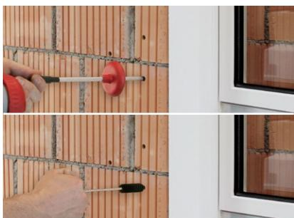
I fori nel calcestruzzo o nelle blocchi pieni, devono essere accuratamente puliti dalla polvere di perforazione.
