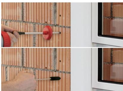
Bohrlöcher müssen bei Beton oder Vollsteinen gründlich vom Bohrstaub gereinigt werden.
