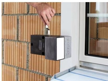
Regolare la posizione della staffa TRA-WIK®-ALU-RL attraverso i piedini di regolazione in modo che sia a filo con la facciata. Campo di regolazione 5 – 15 mm.
