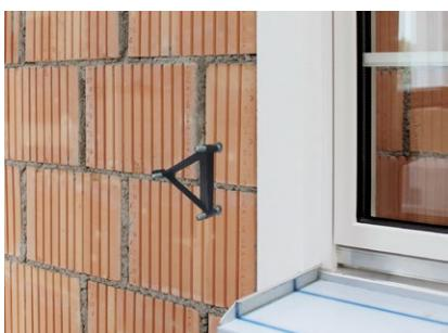
Inserire le aste filettate e posizionarle con esattezza utilizzando il posizionamento calibro per TRA-WIK® e TWL®. Lasciar indurre la malta iniettata. Dopo l'indurimento, rimuovere il posizionamento calibro e il materiale in eccesso. Per quanto riguarda le opere murarie, utilizzare tassativamente delle bussole d'ancoraggio per iniezione.
