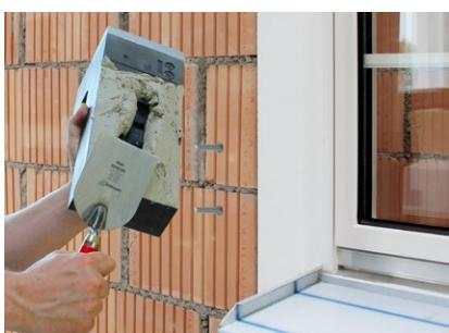
Auf die Klebefläche des Tragwinkels TRA-WIK®-ALU-RL Klebemörtel aufziehen. Element muss vollflächig auf den tragfähigen Untergrund verklebt werden.
