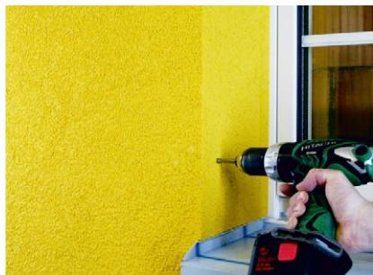
Gewinde durch die Compact- und Aluplatte schneiden.
