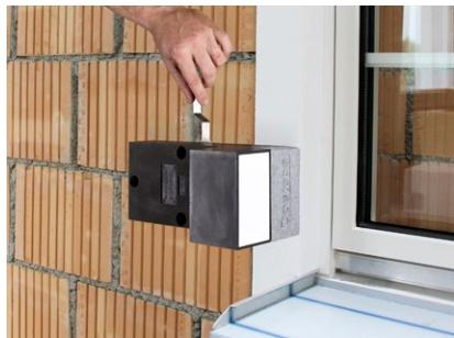
Mit den Stellfüßen Tragwinkel TRA-WIK®-ALU-RL auf Fassadenflucht ausrichten. Verstellbereich 5 – 15 mm.
