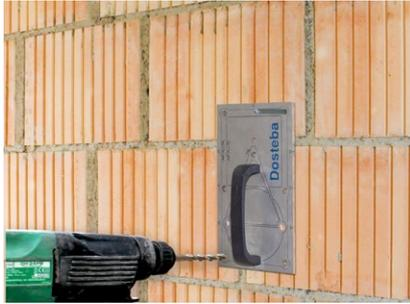
Bei der Bohrlehre für UMP® eine Gewindestange in das dementsprechende Loch stecken.
