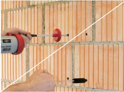
In caso di calcestruzzo e di blocchi pieni eliminare accuratamente la polvere accumulata nei fori.
