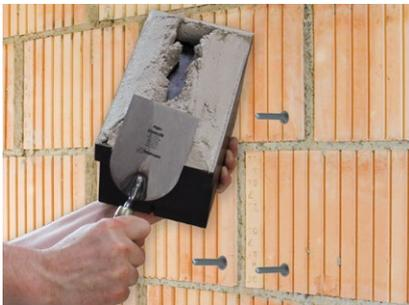
Applicare della malta adesiva sulla superficie d'incollaggio della piastra di montaggio universale UMP®-ALU-TR.
