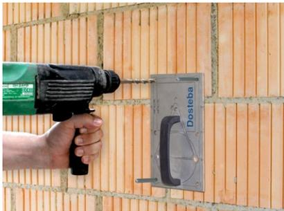
Bei der Bohrlehre für UMP® eine zweite Gewindestange in das dementsprechende Loch stecken.
