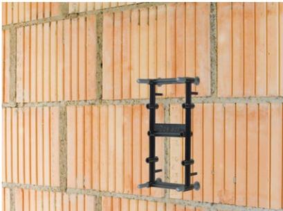
Inserire le aste filettate e posizzarle con esattezza utilizzando il posizionamento calibro per UMP®. Lasciar indurire la malta iniettata. Dopo l'indurimento, rimuovere il posizionamento calibro e il materiale in eccesso. Per quanto riguarda le opere murarie, utilizzare tassativamente delle bussole d'ancoraggio per iniezione.
