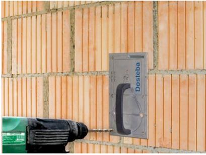
Inserire un'asta filettata nel foro corrispondente della dima di foratura per UMP®.
