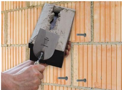
Auf die Klebefläche der Universalmontageplatte UMP®-ALU-TR Klebemörtel aufziehen.
