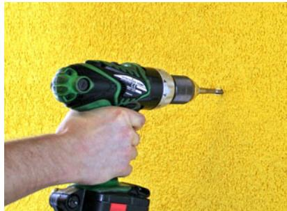
Gewinde durch die Compact- und Aluplatte schneiden.
