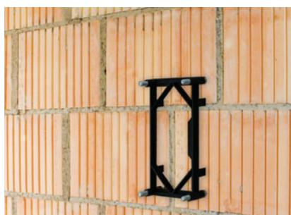
Inserire le aste filettate e posizionarle con esattezza utilizzando il posizionamento calibro per SLK®-ALU-TR. Lasciar indurire la malta iniettata. Dopo l'indurimento, rimuovere il posizionamento calibro e il materiale in eccesso. Per quanto riguarda le opere murarie, utilizzare tassativamente delle bussole d'ancoraggio per iniezione.
