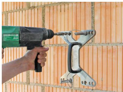
Quando si usa la dima di foratura per SLK®-ALU-TR / -TQ, inserire un secondo perno di posizionamento nel foro corrispondente.
