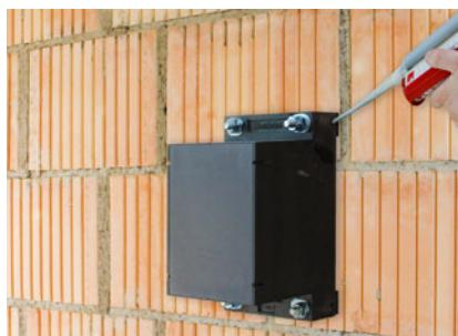
Über die seitlichen Löcher in der Schwerlastkonsole SLK®-ALU-TR Injektions-Mörtel einpressen bis dieser zwischen der Schwerlastkonsole SLK®-ALU-TR und dem Untergrund austritt.
