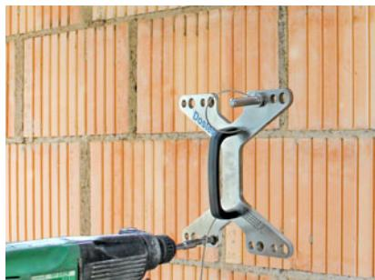
Quando si usa la dima di foratura per SLK®-ALU-TR / -TQ, inserire un perno di posizionamento nel foro corrispondente.
