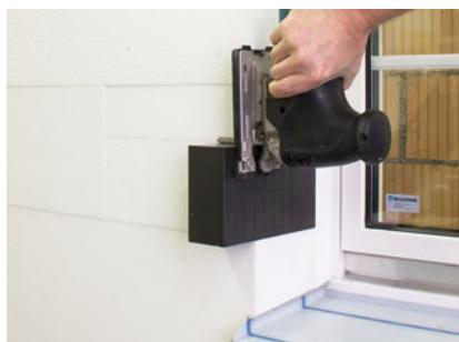
Tragwinkel TRA-WIK®-PU fassadenbündig ablängeln.
