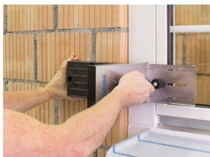
Tragwinkel TRA-WIK®-PU mit aufgeschobener Setzlehre auf die eingezeichnete Höhe halten und Setzlehre bis an den Fensterrahmen führen. Der Strich auf dem Mauerwerk muss durch den mittigen Schlitz in der Setzlehre sichtbar sein. Der Anschlag muss am Fensterrahmen sauber aufliegen.
