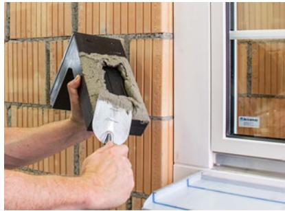
Appicare della malta adesiva sulla superficie d'incollaggio della staffa di montaggio TRA-WIK®-PU.
