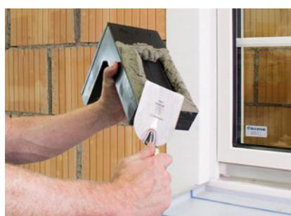
Applicare della malta adesiva sulla superficie d'incollaggio delle staffe di montaggio TRA-WIK®-PU.
