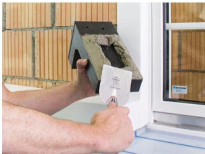
Applicare della malta adesiva sulla superficie d'incollaggio della staffa di montaggio TRA-WIK®-PU.
