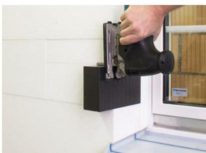
Tragwinkel TRA-WIK®-PU fassadenbündig ablängen.
