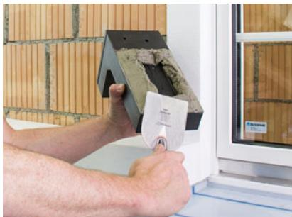
Auf die Klebefläche des Tragwinkels TRA-WIK®-PU Klebemörtel aufziehen.
