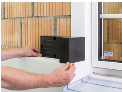
Tragwinkel TRA-WIK®-PU dämmplattenbündig anpressen.
