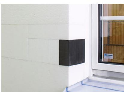
Genaue Lage markieren, damit der Tragwinkel TRA-WIK®-PU nach dem Aufbringen der Putzbeschichtung wieder auffindbar ist.
