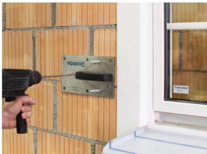
Mit Hilfe der Bohrlehre UMP® / TRA-WIK® / TWL® zweites Bohrloch bohren. Um die Bohrlehre zu fixieren eine Injektions-Gewindestange in das erste Loch stecken.
