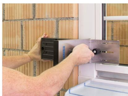
Tenere le staffe di montaggio TRA-WIK®-PU con il calibro di posizionamento inserito all'altezza marcata e portare il calibro di posizionamento a contatto con il telaio della finestra. Il segno sul muro deve essere visibile attraverso la fessura centrale del calibro di posizionamento. La battuta deve aderire bene al telaio della finestra.
