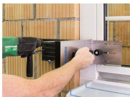
Praticare il primo foro. Trapanare i muri con mattoni forati senza utilizzare la funzione percussione. Inserire il perno di fissaggio nel foro corrispondente e fissare la staffa di montaggio TRA-WIK®-PU.
