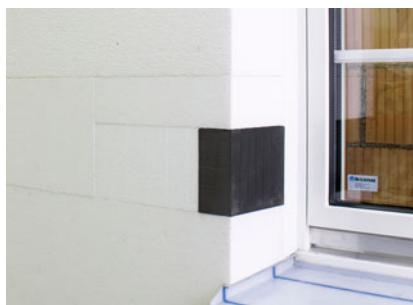
Contrassegnare la posizione precisa, in modo che le staffe di montaggio TRA-WIK®-PU siano nuovamente individuabili dopo l'applicazione del rivestimento in intonaco.
