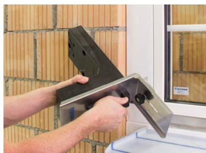
Inserire il calibro di posizionamento sulla staffa di montaggio TRA-WIK®-PU.
