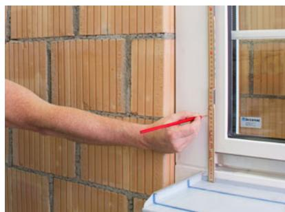
**Montaggio prima dell'incollaggio del pannello isolante**
