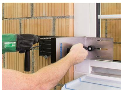
Erstes Bohrloch bohren. Mauerwerke mit Lochsteinen ohne Schlag bohren. Schraubdübel in das dementsprechende Loch stecken und Tragwinkel TRA-WIK®-PU fixieren.
