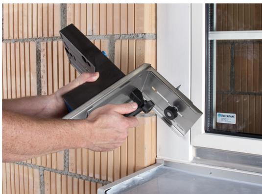
Setzlehre auf Klobentragelement K1-PE oder Tragwinkel TRA-WIK®-PU aufschieben.
