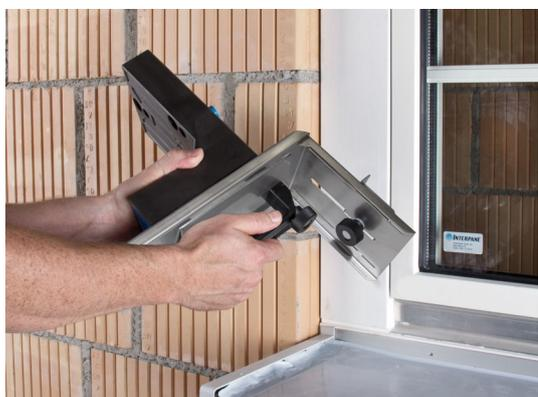
Inserire il posizionamento calibro sul supporto per imposte K1-PE o staffe di montaggio TRA-WIK®-PU.
