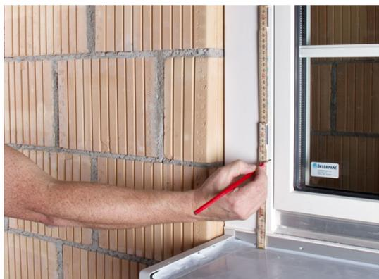
Il est recommandé de poser les éléments pour fixation des gonds K1-PE et equerres TRA-WIK®-PU avant de coller les panneaux isolants.
