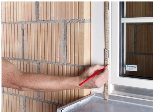
Si raccomanda di applicare i supporti per imposte K1-PE e staffe di montaggio TRA-WIK®-PU prima di incollare i pannelli isolanti.
