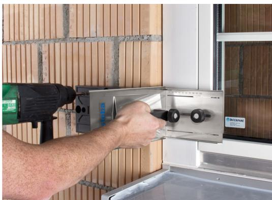
Erstes Bohrloch bohren.
