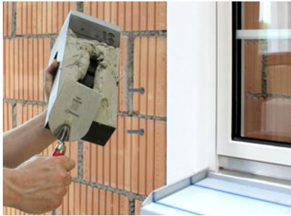
Unterlage auf Tragwinkel TWL®-ALU-RF setzen.
