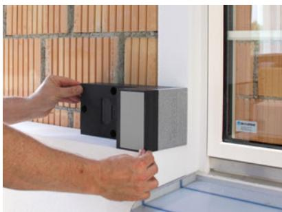
Tragwinkel TWL®-ALU-RF dämmplattenbündig anpressen.
