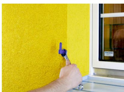
lunghezza delle viti necessaria dipende dalla profondità dell'avvitamento, dallo spessore del rivestimento e dallo spessore del componente.
