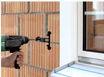
Mit Hilfe der Unterlage zweites Bohrloch bohren.
