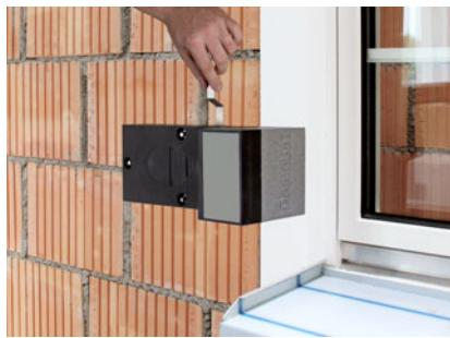
Regolare la posizione dell'staffa di montaggio TWL®-ALU-RF attraverso i piedini di regolazione in modo che sia a filo con la facciata. Campo di regolazione 5–15 mm.
