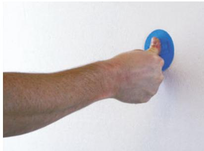
Premere il cilindro di montaggio ZyRillo®-PE a filo dei pannelli isolanti nella sezione fresata.
