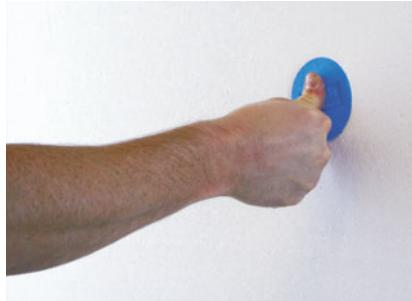
Montagezylinder ZyRillo®-PE dämmplattenbündig in die Ausfräzung pressen.
