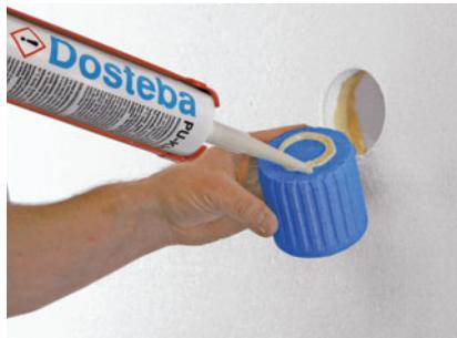
Appicare della colla-PU DoPurCol, in stick o in pasta, sulla superficie circolare del cilin-dro di montaggio ZyRillo®-PE.
