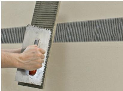
I profili per la facciata Do-Pro devono essere incollati su un sottofondo stabile, asciutto, privo di polvere e grasso. Il sottofondo deve essere piano. Con il sistema di isolamento termico i profili per facciata Do-Pro devono essere incollati all'intonaco di fondo. Stendere la malta adesiva con una spatola dentata sul sottofondo e sulla superficie adesiva del profilo per facciata Do-Pro.
