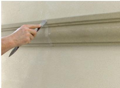
Stossfugen mit Beschichtungsmasse BMA verschliessen.
