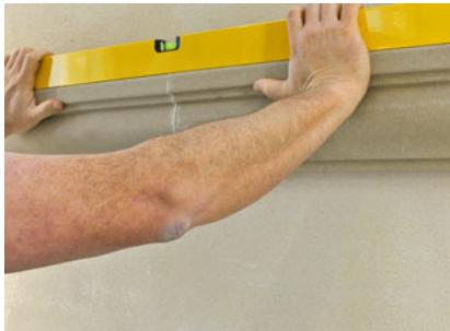
Premere bene insieme i due profili. Per ottenere una registrazione esatta dei profili, bisognerebbe lavorare con un regolo. Nel caso di profili più grandi dovrebbe fissata al muro anche una barra rettilinea. Se necessario fissare i profili per facciata Do-Pro affinché non scivolino.
