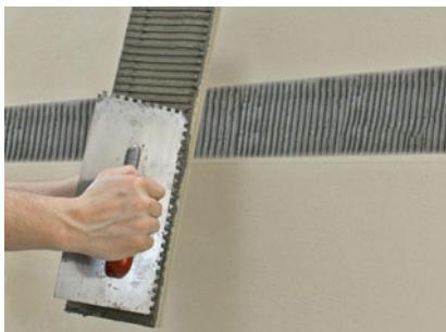
Aufkleben der Fassadenprofile Do-Pro auf stabile, trockene, staub- und fettfreie Untergründe. Der Untergrund muss eben sein. Bei Wärmedämmverbundsystemen sollten die Fassadenprofile Do-Pro auf den Grundputz geklebt werden. Klebmörtel mit einem Zahnpachtel vollflächig auf dem Untergrund sowie auf der Klebefläche des Fassadenprofiles Do-Pro auftragen.
