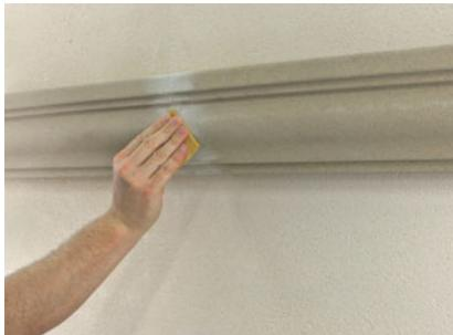
Nach dem Aushärten der Beschichtungs-masse BMA kann die Oberfläche mit Schleifpapier nachbearbeitet werden.
