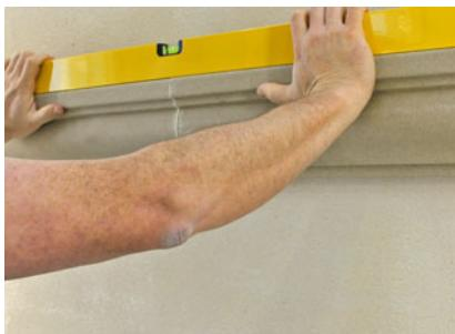
Profile satt und fest andrücken. Um eine exakte Ausrichtung der Profile zu erhalten, sollte mit einer Richtlatte gearbeitet werden. Bei grösseren Profilen sollte zusätzlich eine gerade Latte an der Wand befestigt werden. Wenn notwendig sind die Fassadenprofile Do-Pro gegen Verrutschen zu fixieren.
