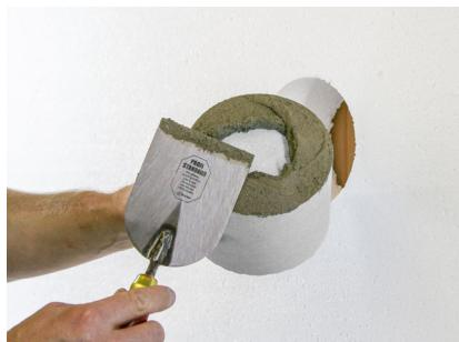
Appicare della malta adesiva sulla superficie circolare del cilindro di montaggio VARIZ®. L'elemento deve essere incollato coprendo la totalità della superficie sul fondo portante.
