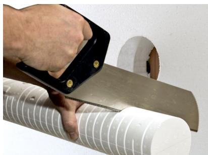
Montagezylinder VARIZ® mit einer Handsäge oder einem Glühdrahtschneidegerät auf erforderliche Dämmdicke ablängen.
