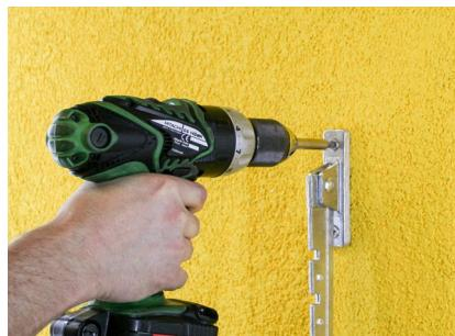
Avvitare componenti nel cilindro di montaggio VARIZ®.
