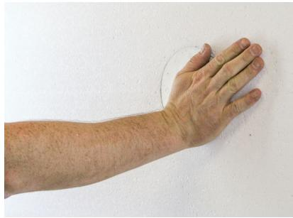
Premere i cilindri di montaggio VARIZ® a filo dei pannelli isolanti.
