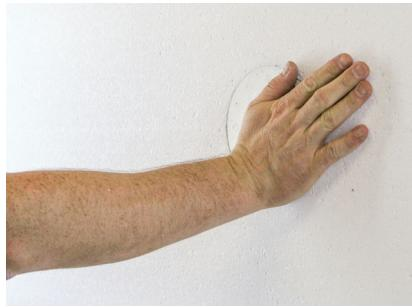
Montagezylinder VARIZ® dämmplattenbündig in die Ausfräzung pressen.
