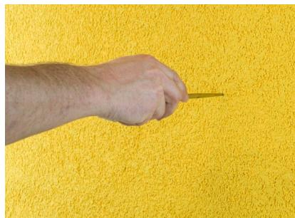
La vite potrà essere inserita più facilmente, eseguendo un foro con un punteruolo. Non è necessario eseguire una preperforazione.
