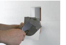
Applicare della malta adesiva sulla superficie d'incollaggio del blocco di montaggio Quadroline®-EPS. L'elemento deve essere incollato coprendo la totalità della superficie sul fondo portante.
