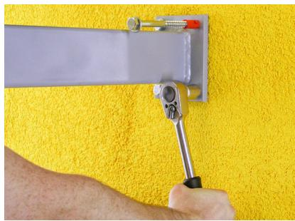
Anbauteil mit Schraubdübeln oder Injektions-Gewindestangen im Mauerwerk verankern.
