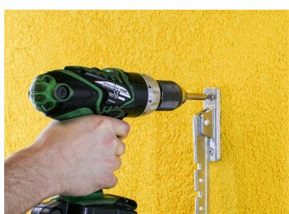
Anbauteil im Montagezylinder Rondoline®-PU verschrauben.
