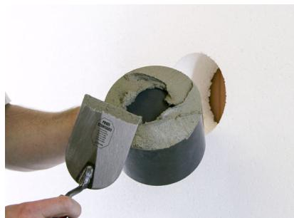
Auf die Kreisfläche des Montagezylinders Rondoline®-PU Klebemörtel aufziehen. Element muss vollflächig auf den tragfähigen Untergrund verklebt werden.
