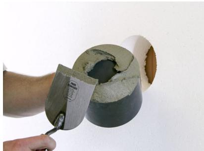
Appicare della malta adesiva sulla superficie circolare del cilindro di montaggio Rondoline®-PU. L'elemento deve essere incollato coprendo la totalità della superficie sul fondo portante.
