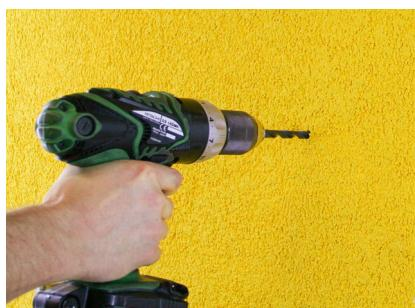
Bei grossen Schraubendurchmessern kann vorbohren von Vorteil sein, um ein Spalten des Montagezylinders Rondoline®-PU zu verhindern.
