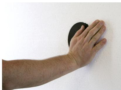
Montagezylinder Rondoline®-PU dämmplattbündig in die Ausfräzung pressen.
