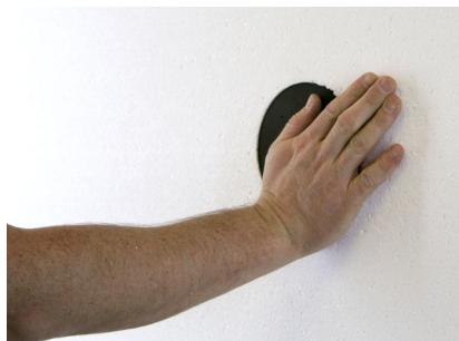
Premere il cilindro di montaggio Rondoline®-PU a filo dei pannelli isolanti nella sezione fresa.
