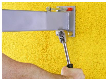
Aggiornare la componente alle opere mura-rie con dei perni di fissaggio o aste filettate per iniezione.
