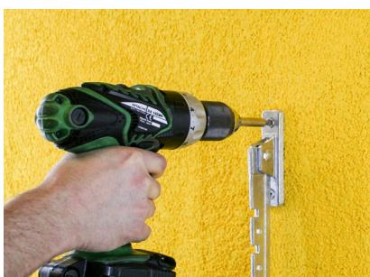
Avvitare la componente nel cilindro di montaggio Rondoline®-PU.
